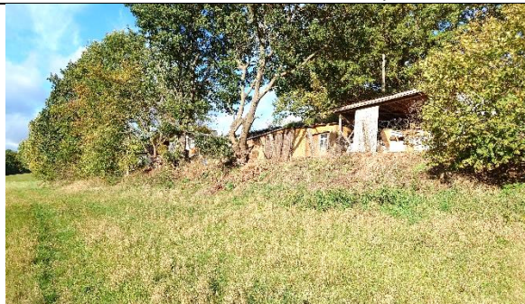
Nebengebäude auf Flst. 158/3
