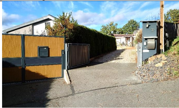
Einfamilienhäuser Nr. 3a, 3b auf Flst. 158/2, 158/1
