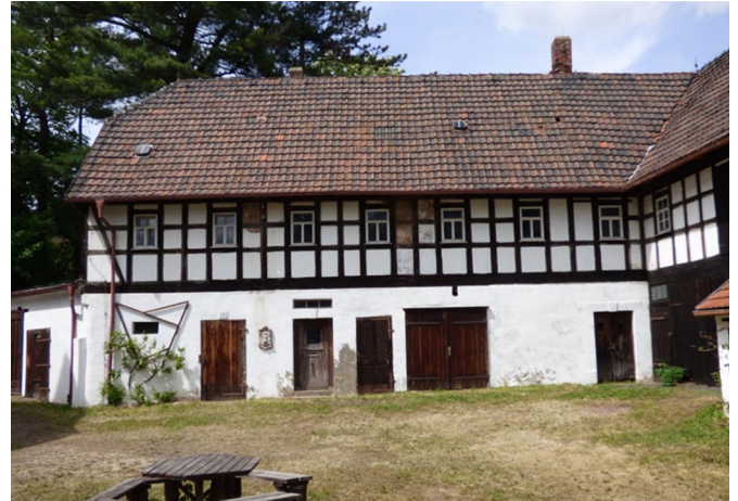
Gräfenmühle – Nordflügel (Foto: Reinhold)
