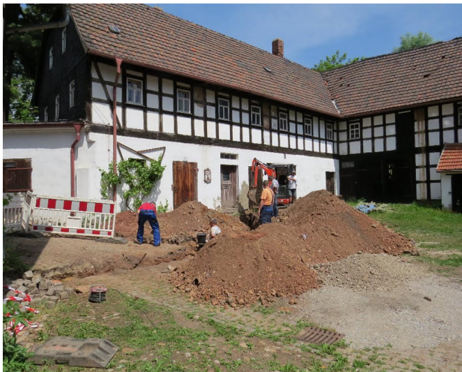
Bauarbeiten – Tiefbauarbeiten auf dem Mühlenhof (Fotos: Albani)
