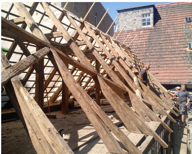
Dachdecker und Zimmerleute legen los (Foto: Albani)
