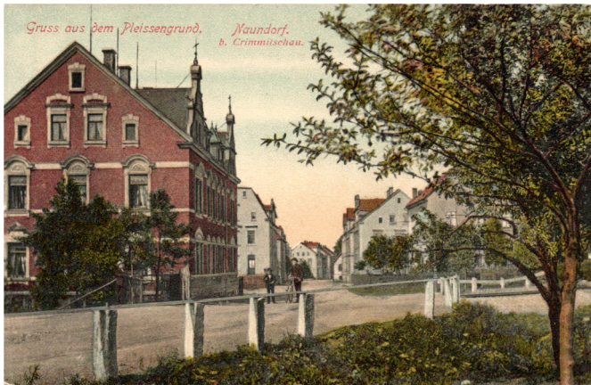
Blick auf die Hauptstraße um 1910, rechts der Abzweig zur „Siedlung“
