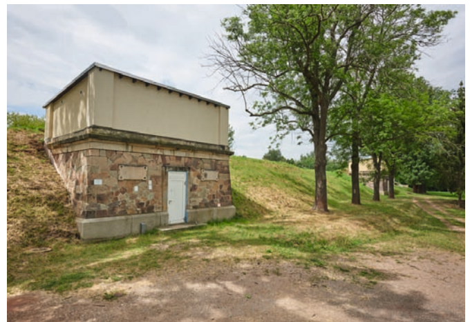
52 Trinkwasserbehälter wie dieser sind Bestandteil unserer Trinkwasserversorgung.
