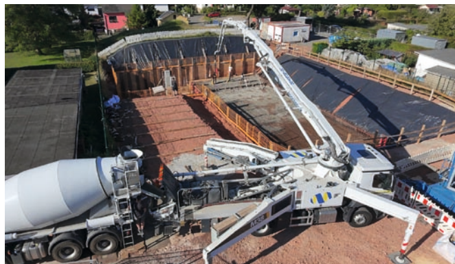
Ersatzneubau des Trinkwasserhochbehälters Crimmitschau West
