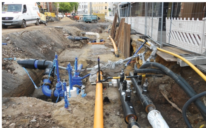
Rohrnetzerneuerung und Kanalnetzerneuerung in Zwickau, Bosestraße/Georgenplatz
