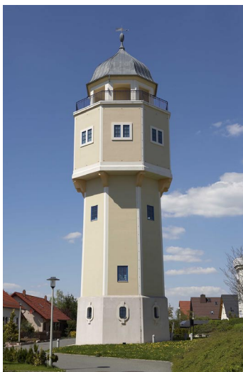
Wasserturm in Oberplanitz
