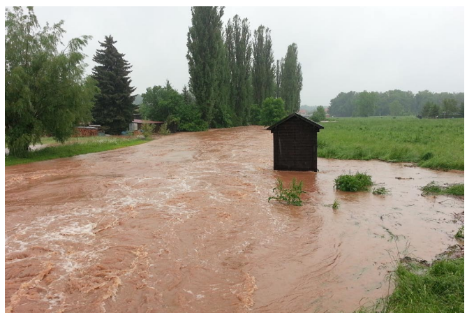
Blick auf das Pegelhaus Bosenhofweg am 2. Juni 2013
