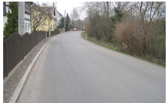
Grundhafter Straßenausbau der Hauptstraße
