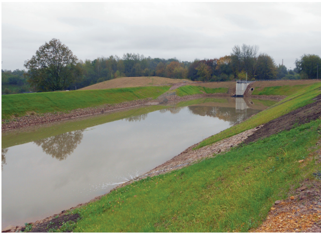
Regenrückhaltebecken am Standort Industriegebiet Reichenbacher Straße
